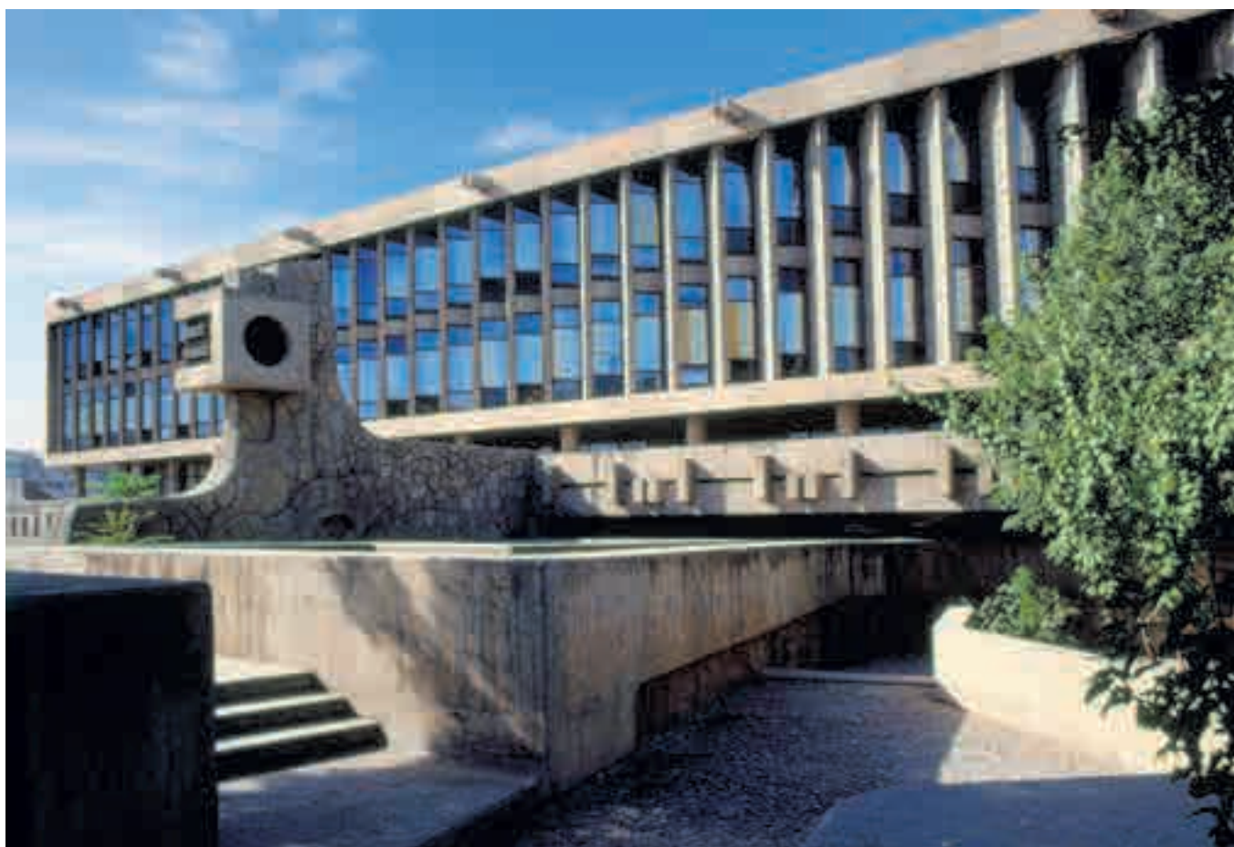
Döwlet kitaphanasynyň binasy. 1964-1975 ýý. Binagär Abdylly Ahmedow
