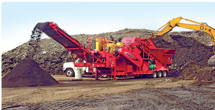
84-nji surat. Ýörite tehnikalaryň kömegi bilen sökülän asfaltyň täzeden ulanyma taýýarlanylşy
