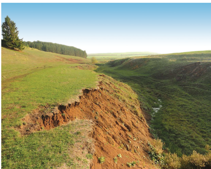
92-nji surat. Kanalyň boýunda yzgarlap çökme jaýryklary
