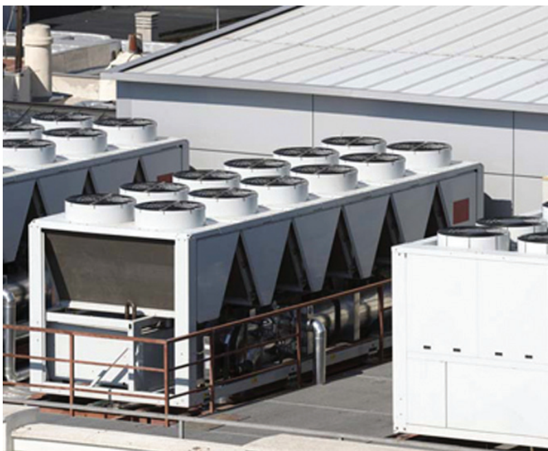
76-njy surat. Howa bilen sowadylýan iki sudurly kompressor-kondensator agregatyň daşky görnüşi
